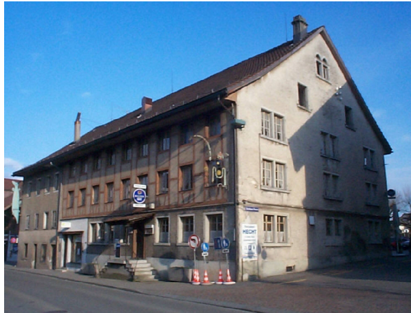
Strassenfassade vor Sanierung/ Aufstockung
