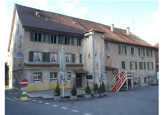
Strassenfassade vor Sanierung/ Aufstockung
